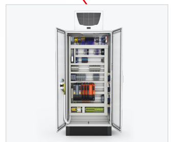
Die Stuerelektronik , Sicherheitstechnik und der Industrie-PC sind im Schaltschrank verbaut.
